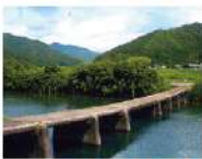
一斗俵の沈下橋
